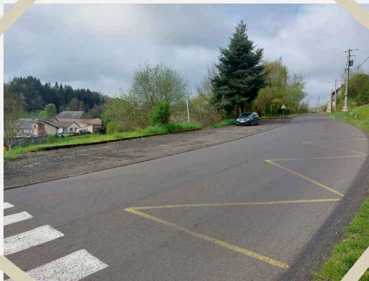
Figure 113 : Aire de covoiturage située à Gelles
