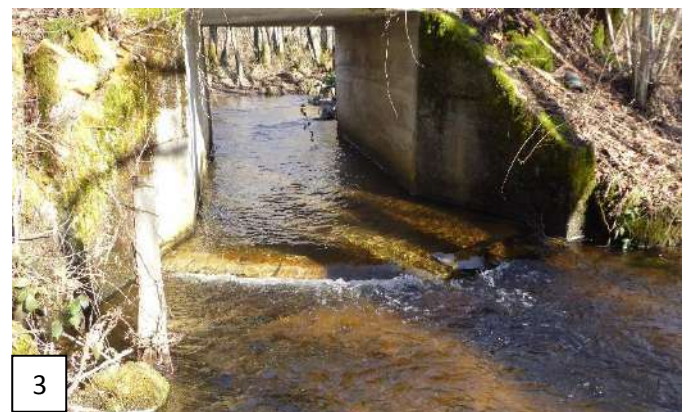
Figure 5 - Photos avant (1), pendant (2) et après (3) l'aménagement d'un radier pour rétablir la continuité écologique
