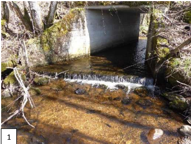
Figure 5 - Photos avant (1), pendant (2) et après (3) l'aménagement d'un radier pour rétablir la continuité écologique
